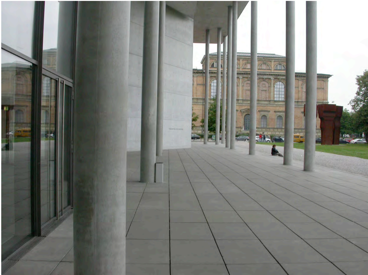
München: Pinakothek der Moderne (Eingang mit Säulenkolonnaden)
